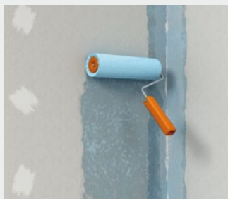
Afb. 18: fermacell Diepgrond aanbrengen op het hele oppervlak
