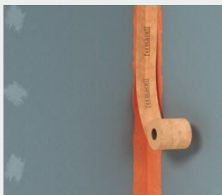
Afb. 19a: fermacell Afdichtband aanbrengen in de eerder aangebrachte, nog vochtige laag fermacell Vloeibare folie ...
