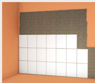
Afb. 24: Tegels worden geplaatst met een dunne laag fermacell Flexibele tegellijm op een volvlakse afdichting (garandeert de afdichting voor de vochtbelastingsklasse A).
